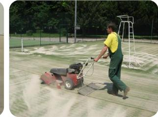
*Insertion de la matière de lestage et redressement des fibres*
